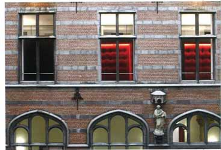
Detaliu al fațadei interioare către atrium. Facade towards the atrium (detail).
