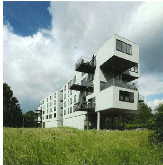
Appartement Eendenpoel | VBMarchitecten (nu BOGDAN & VAN BROECK ARCHITECTS en LAVA ARCHITECTEN) © Philippe Van Gelooven
